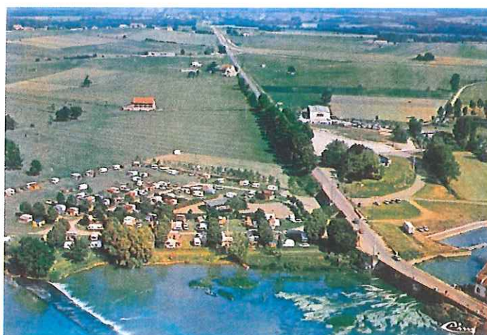
Les installations du camping en rive gauche
