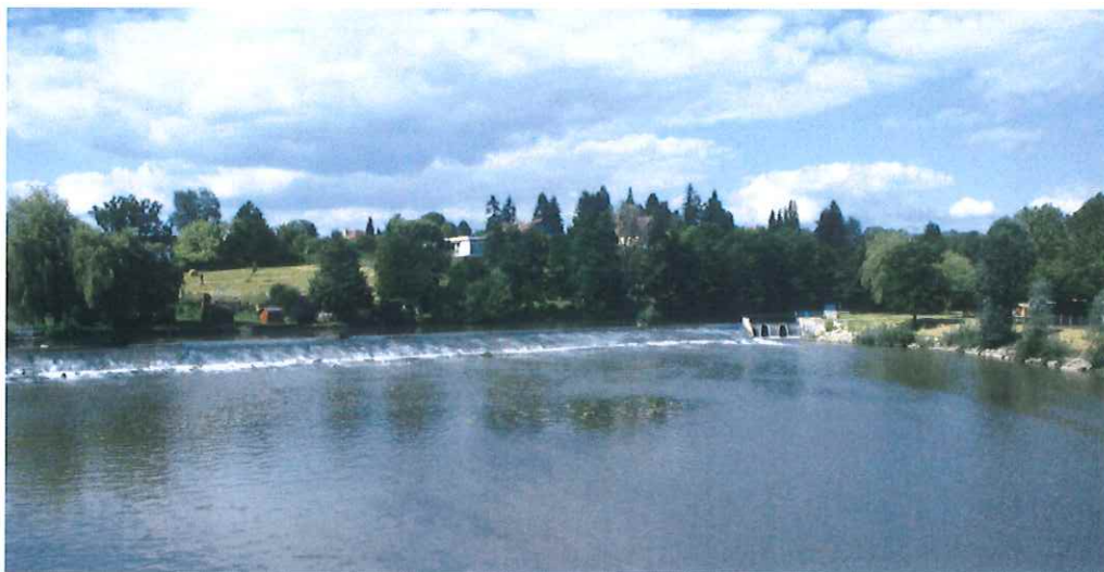
Le barrage sur l'Ognon
