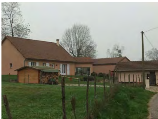
Constructions récentes à Rérafay
