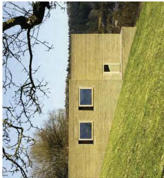
Des constructions contemporaines en pisé dans le Forêt (ci-dessous) et dans le Vorarlberg en Autriche (ci-contre).
