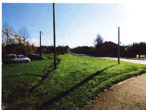
La noue entre le lotissement et le RD17
