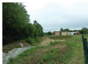
Bassin de rétention
