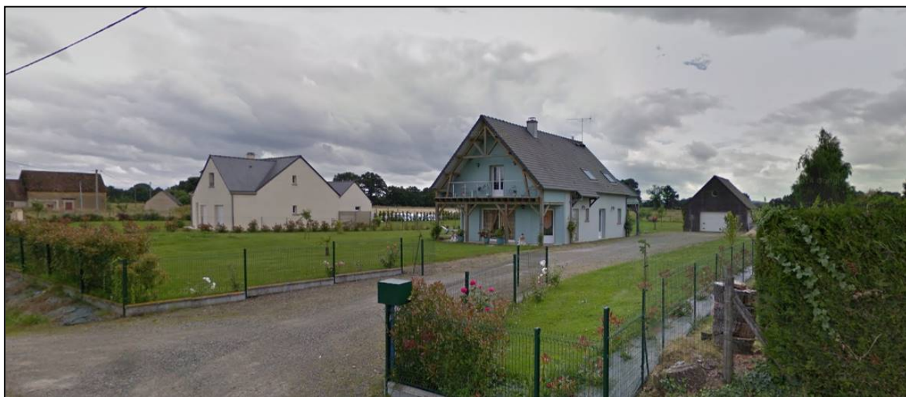
Constructions neuves dans le secteur des Conillères
