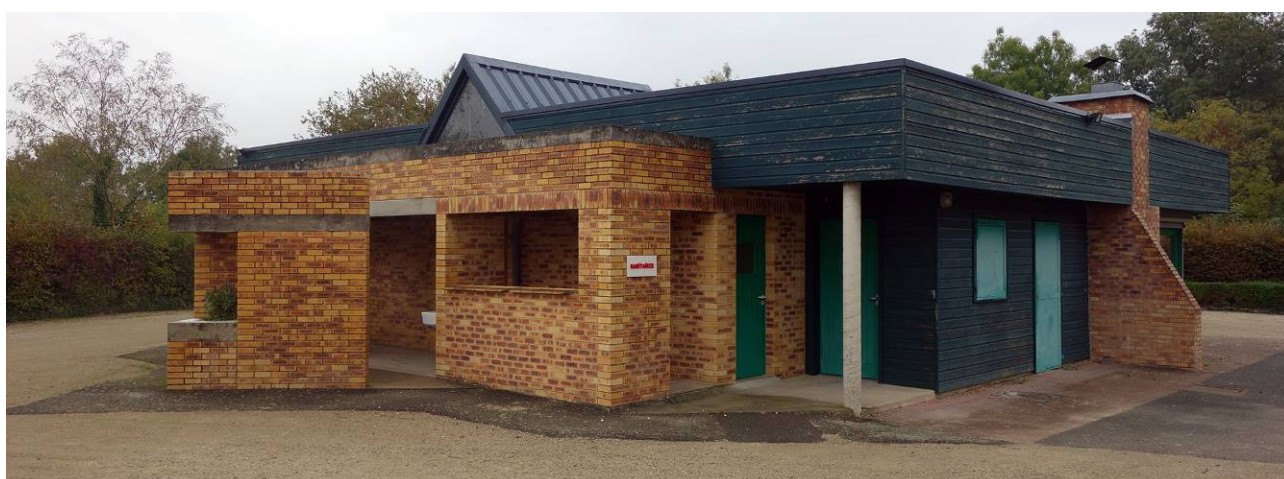
Le gîte d'accueil du camping du Pont d'Orne
