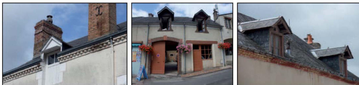
Photo 3. Autre exemple de détail de toiture, double génoise en brique.
