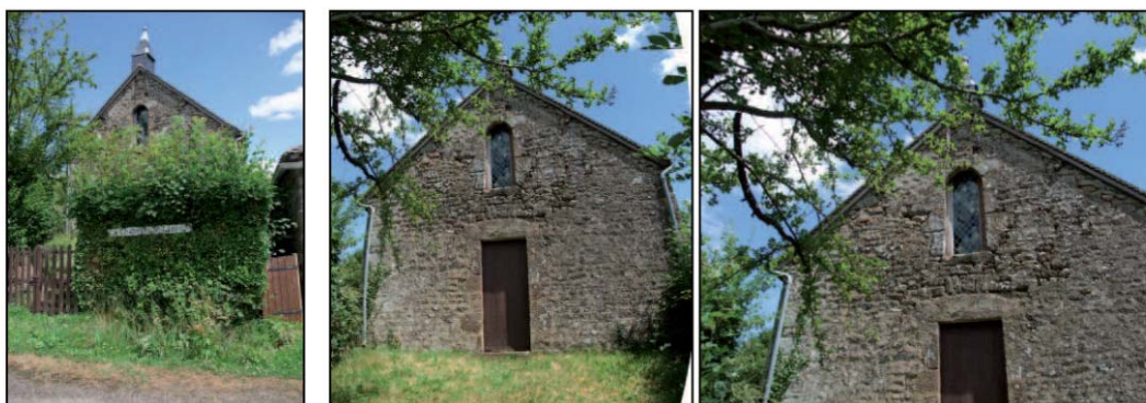
Photos du pignon de la chapelle St Laurent.
