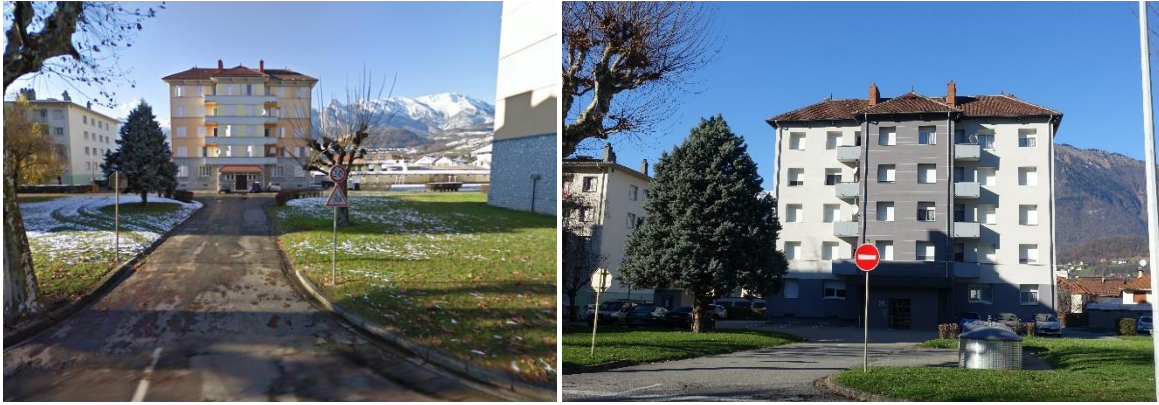
Opération de réhabilitation Avenue du Champ de Mars
