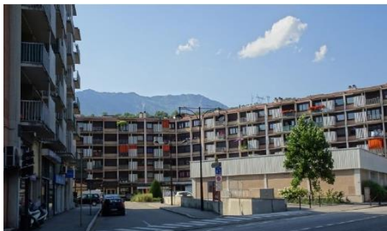
Quai des Allobroges après rénovation en 1963
