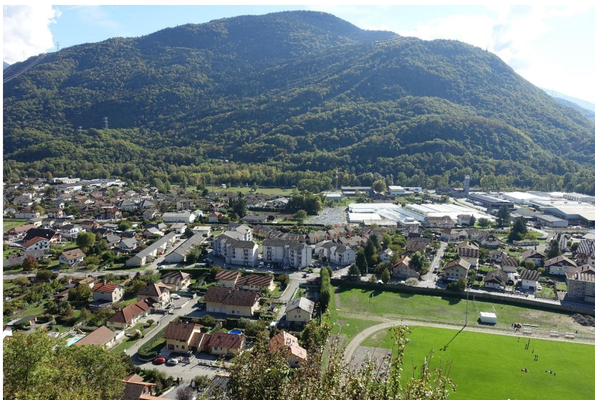
Le versant boisé du Grand Arc traversé par les lignes électriques depuis la Cité de Conflans
