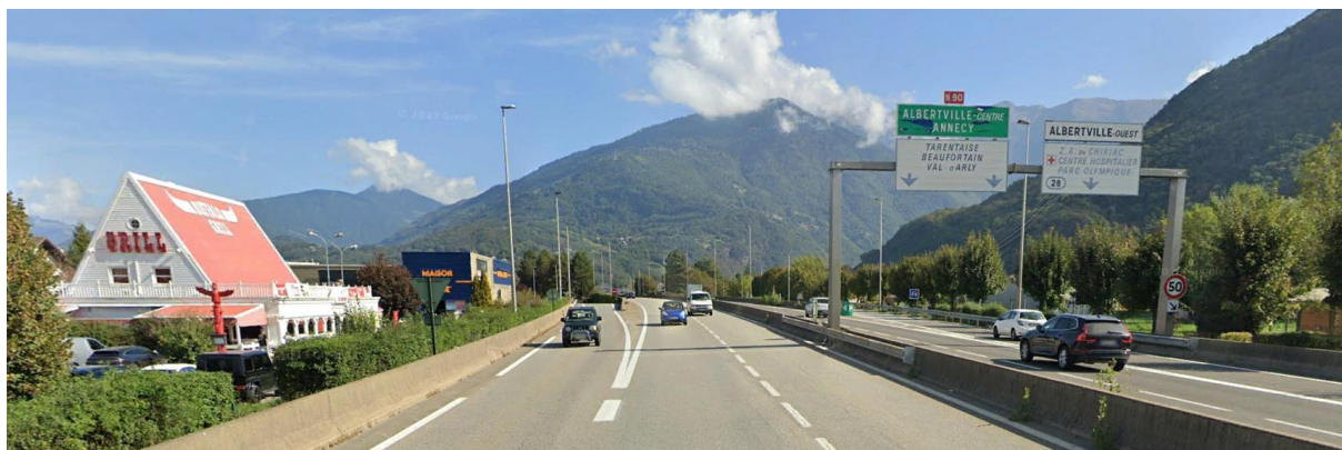
Les abords de la RN à hauteur de la ZA du Chiriac
