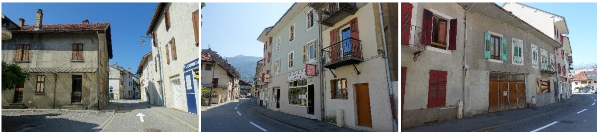
Constructions et espaces publics de la rue Suarez
