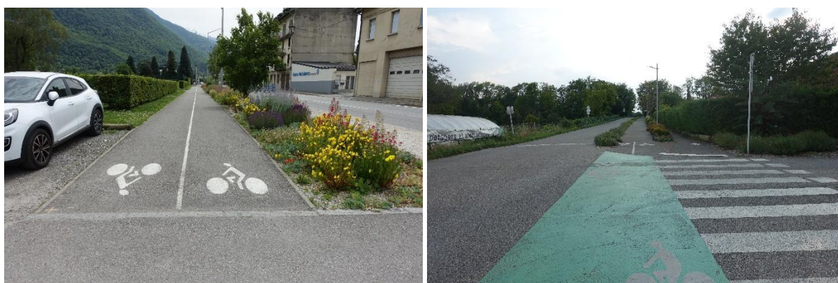
Exemples d'aménagements cyclables qualitatifs, Albertville Avenue des Chasseurs Alpains, Crolles Rue de la Bouverie
