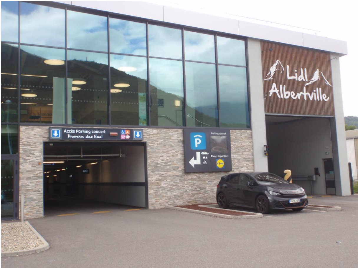
Exemple de stationnement sous le bâtiment, Lidl, Albertville
