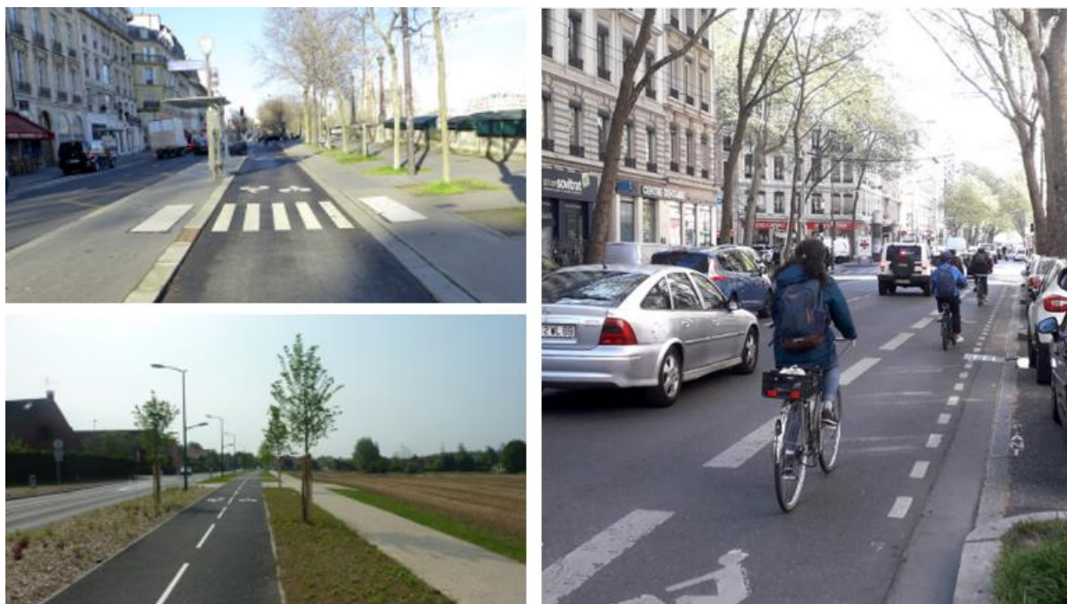
Exemples d'aménagements cyclables qualitatifs. Source : Cahier « Rendre sa voirie cyclable », CEREMA, 2023
