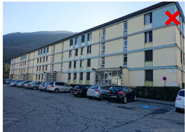
Aire de stationnement imperméabilisée Champ de Mars Albertville
