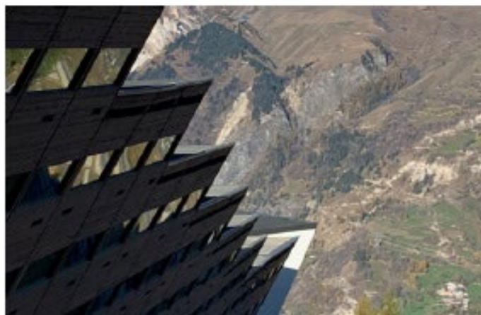
La Cascade : immeuble couché dans la pente et aux façades inclinées
