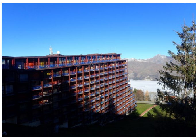
Entité Charvet Nord, immeuble Pierra Menta © Alpicité
