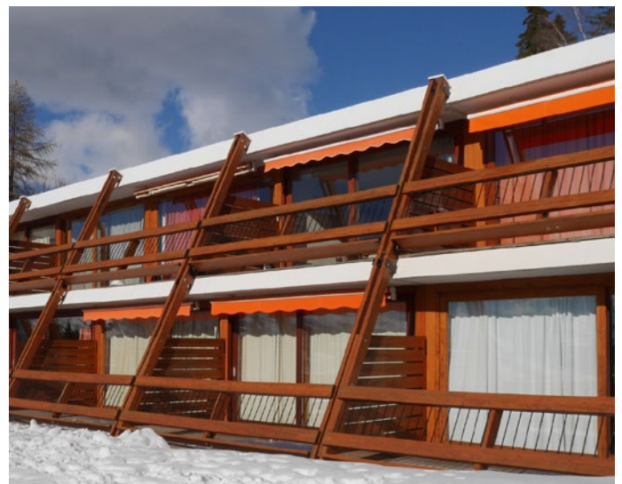
Le Haut de l'Adret : immeuble suivant les courbes de niveaux
