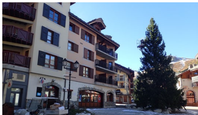
Exemple de logements collectifs en R+3+attique à Arc 1950 Source : Alpicité
