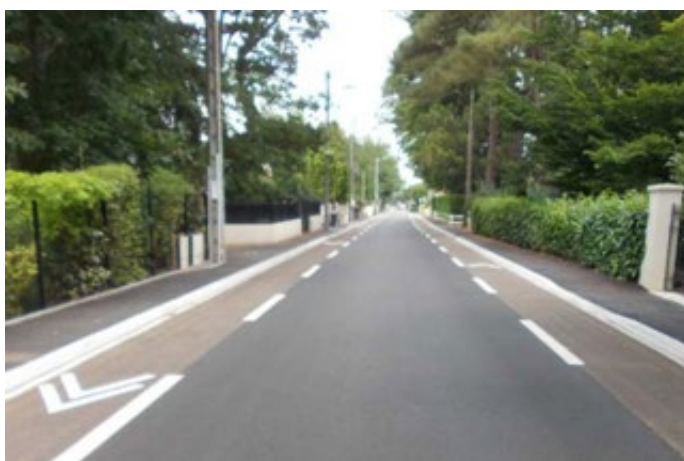
Chaussée à voie centrale banalisée (CVCB - Chaucidou)
