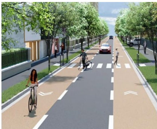
Chaussées à voie centrale banalisée
