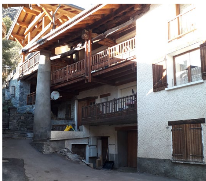
Ferme à colonne au Châtelard
