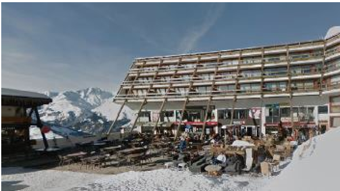
Terrasses de la Place du Soleil © Archipat
