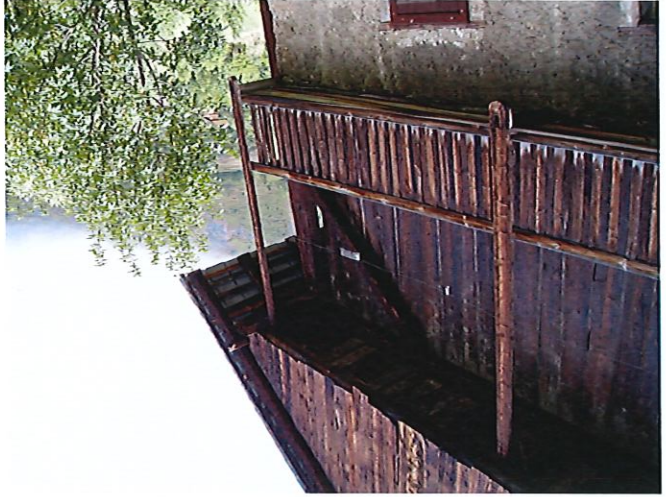
Détail de la structure porteuse : suspente et solive
