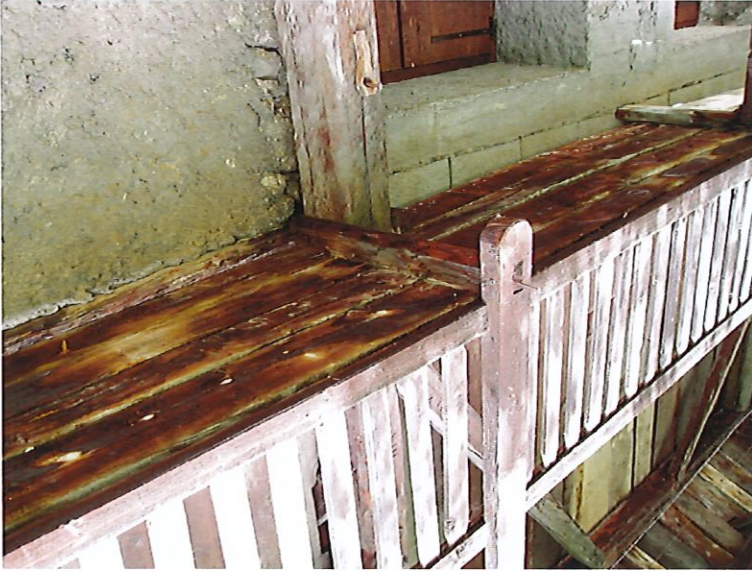
Détail de la structure porteuse : suspente et solive
