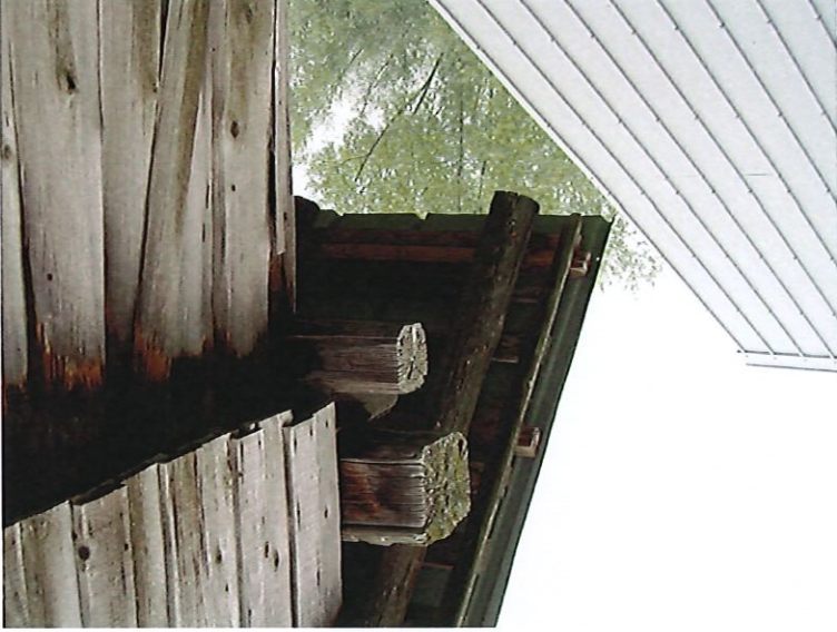
Détails du débord de la couverture par rapport aux plans du bardage d'une trentaine de cm
