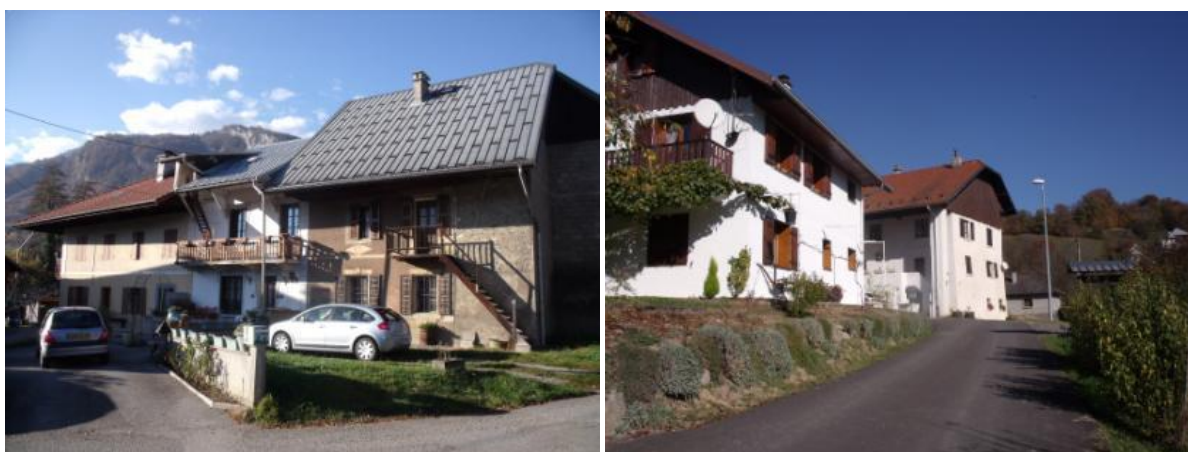
Exemples de constructions au sein d'hameaux anciens de Mercury, Epoque
