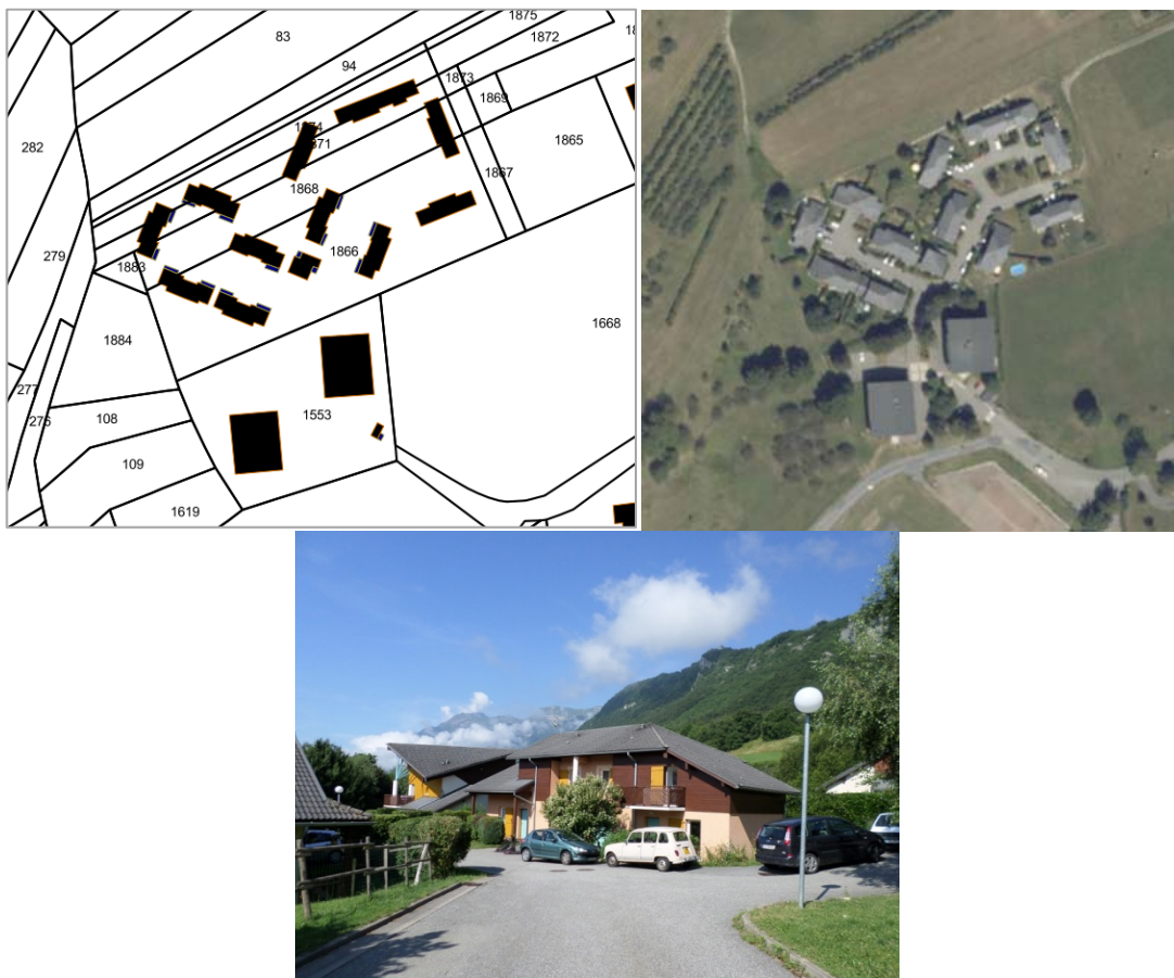
L'habitat résidentiel collectif : photo aérienne, parcellaire/morphologie bâtie, et photo au sol, Epode
