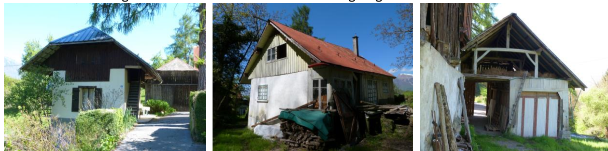
De gauche à droite : résidence secondaire et anciennes granges. Passage chemin sous grange
