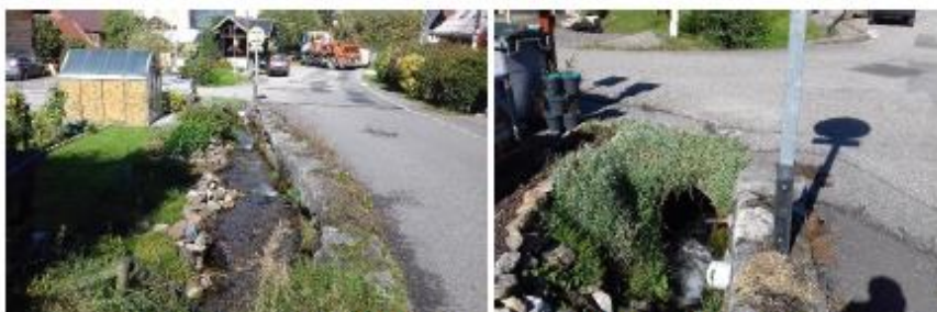
Figure 4 : exemple de franchissements sur la traversée de Monthion
