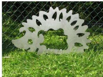
Exemples des percements dans les clôtures perméables à la faune
