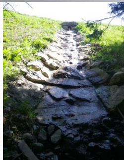
Cunette en enrochements bétonnés servant d'exutoire
