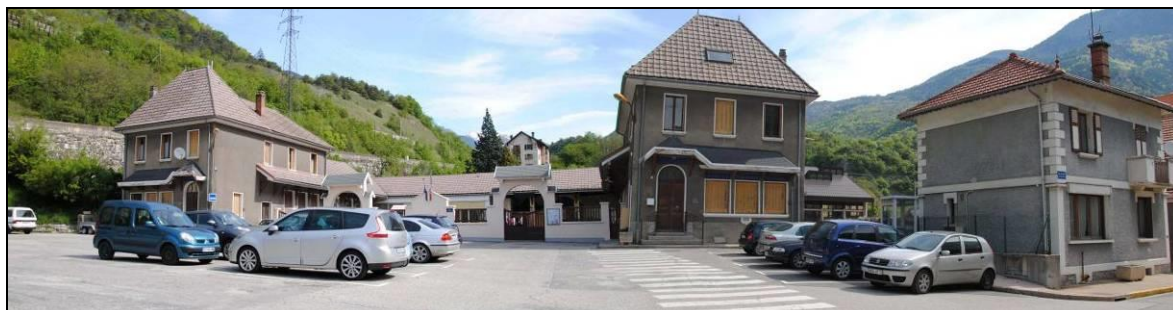
Photo 11 : Bâtiments des anciens services de Pomblière
