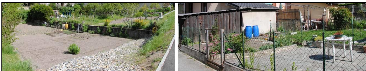
Photo 2 : Jardins ouvriers en contrebas de la route principale traversant Pomblière
