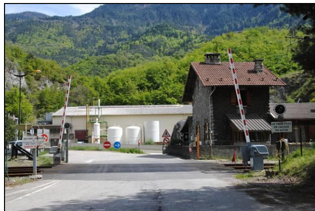
Photo 30 : Stockages de MSSA à proximité de la gare
