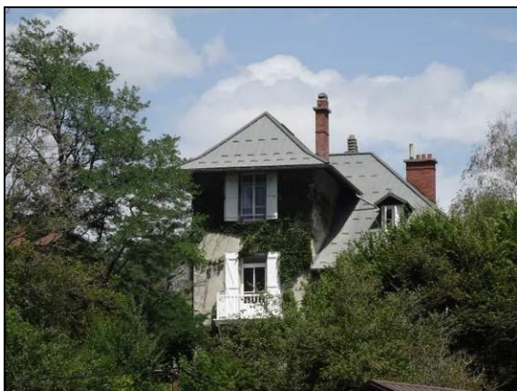
Photo 64 : Maison de maître à Pomblière
