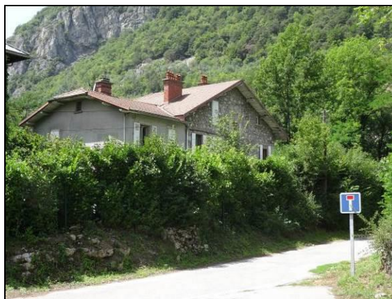
Photo 65 : Maison de maître à Pomblière
