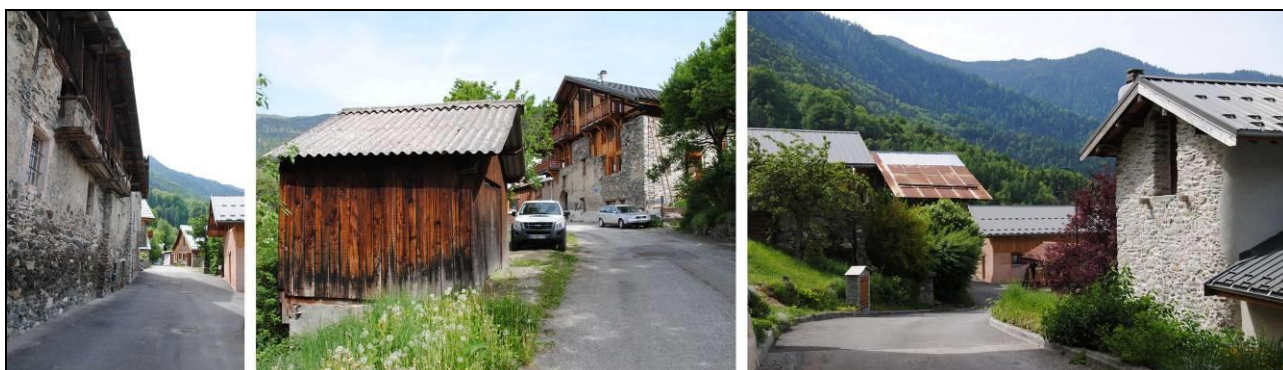
Photo 48 : Façades à dominance de pierre ; quelques éléments en bois
