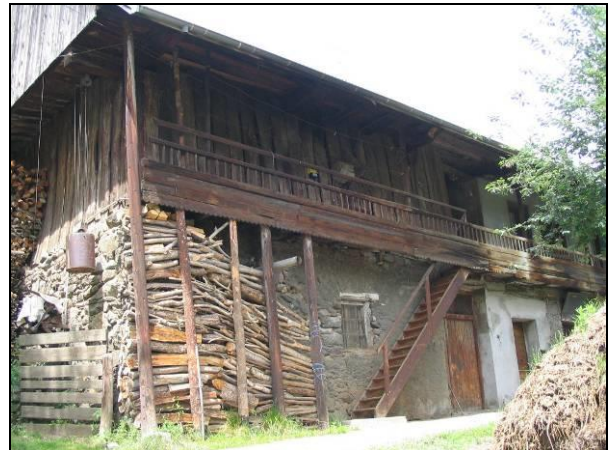
Photo 67 : Soubassement maçonné, bardage et balcon bois, ouvertures marquées
