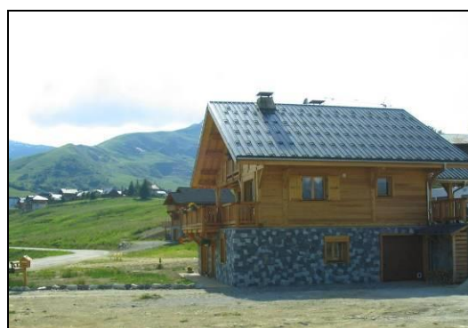
Photo 73 : Chalets en pierres taillées et système de poteaux poutre
