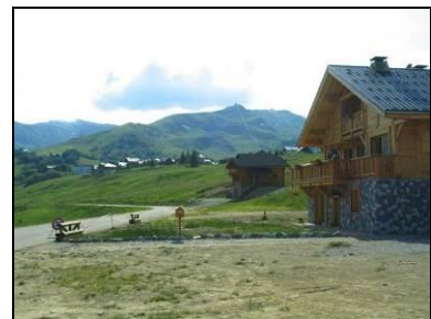
Photo 53 : Vue sur la rupture de pente en aval de Praz Rivier
