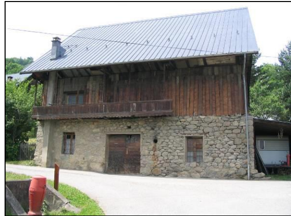
Photo 65 : Soubassement en pierres apparentes, bardage et balcon bois
