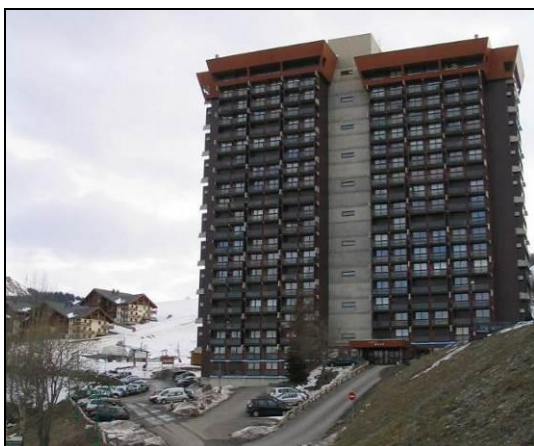
Photo 49 : Contraste immeubles des années 1968 et résidences récentes en arrière-plan – nudité du site
