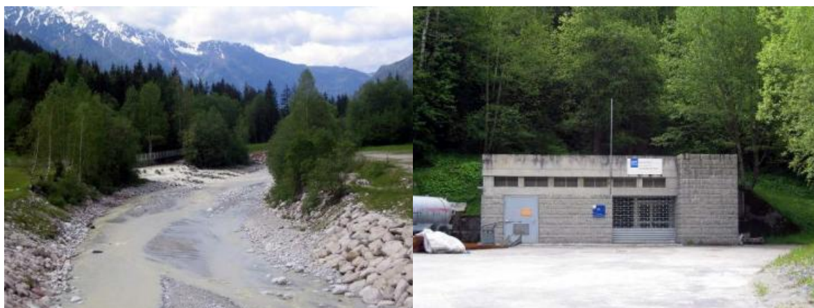
Figure 44 : A droite : REJET du torrent sous-glaciaire de la Mer de Glaciaire dans l'Arveyron ; à gauche : usine hydroélectrique des Bois
