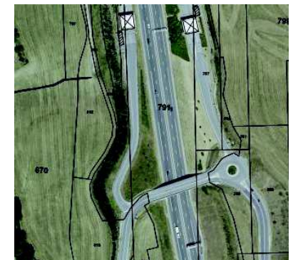
Passage sur le pont au-dessus de l'A41
