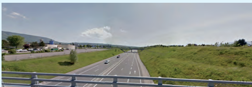
L'A41 vue depuis le pont de la route de Chez Le Clerc
