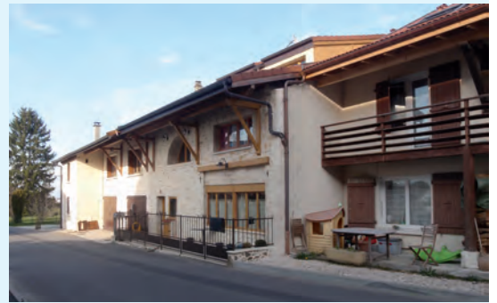
Ensemble patrimonial au Biolay
