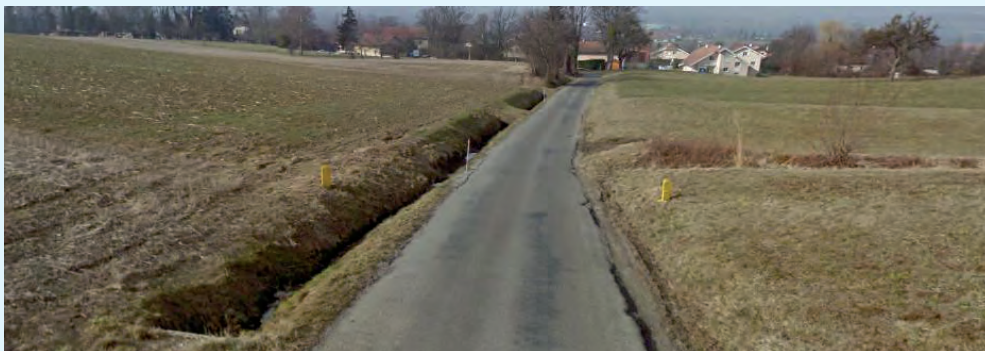
Borne de localisation du gazoduc au droit du chemin de la Chapelle
