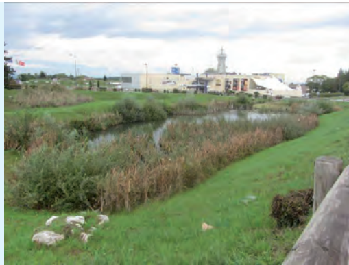
Bassin de gestion des eaux pluviales du secteur des Envignes - SETIS
