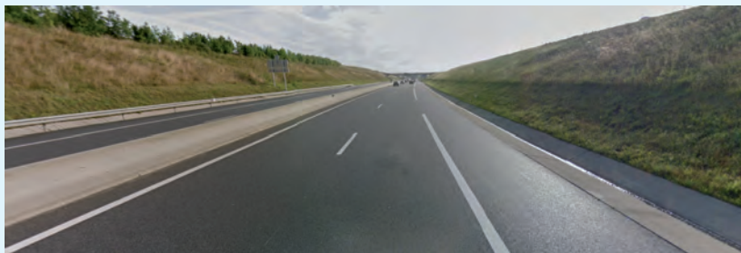
Vue depuis une partie encaissée de l'autoroute A41
