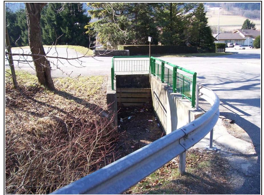
Figure V.6: Ouvrage d'entonnement du ruisseau des Airets sous la RD26.
