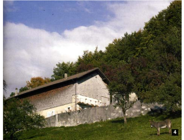
Ferme isolée – Façade et pignon en tavaillons – Les Crozats
