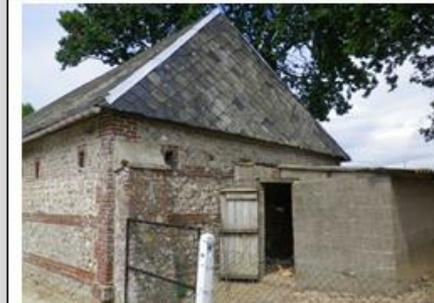
**Matériaux** : brique & silex, construction jointive en parpaings**État** : bon
