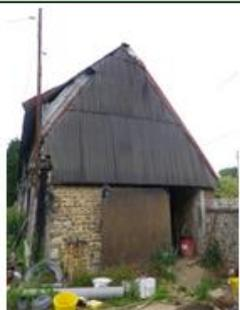
**Matériaux** : silex sur la partie basse, tôle ondulée sur la partie haute**État** : moyen
