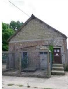
**Matériaux** : brique, parpaings en béton sur la partie haute
