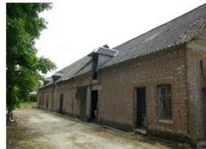
**Matériaux** : brique sur la partie Nord, brique et silex sur la partie Sud
