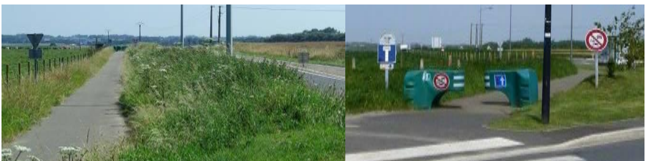
Aménagement de la Véloroute
