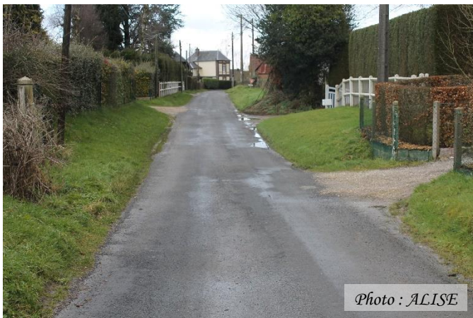
Photo n°56 Point bas de la rue Verte
