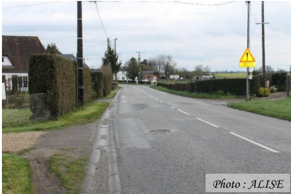
Photo n°29 Caniveau longeant la rue de l'Eglise
