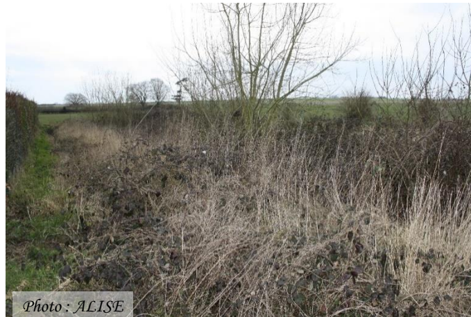
Photo n°32 Ouvrage OUV_07 gérant les eaux pluviales du lotissement des Pommiers
