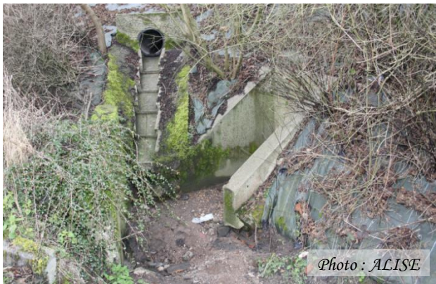
Photo n°37 Sortie du dalot et de la canalisation 300 mm dans le fossé
