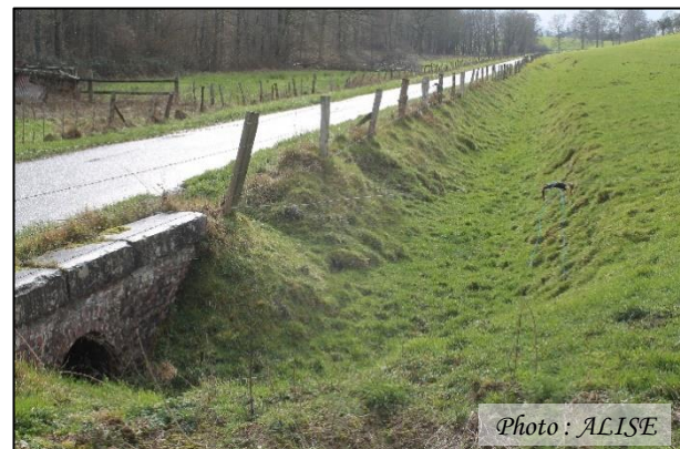
Photo n°16 Voûte sous RD 90
