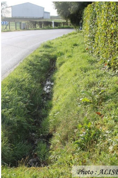
Photo n°27 Fossé présent le long de la rue de l'Eglise
