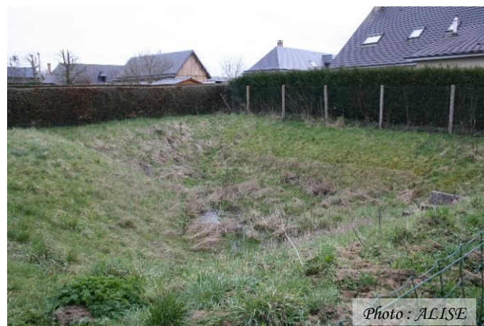
Photo n°41 Bassin de rétention et d'infiltration du lotissement des clos (OUV_02)
