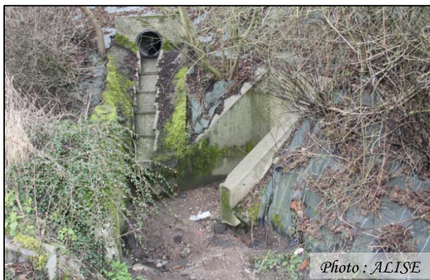
Photo n°11 Sortie du dalot et de la canalisation 300 mm dans le fossé
