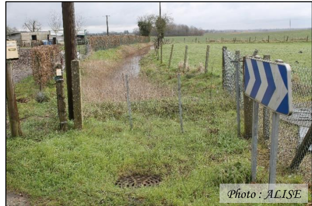
Photo n°22 Fossé en aval de la rue de l'Eglise
