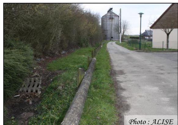
Photo n°12 Vue vers l'aval du fossé longeant la rue du Moulin
