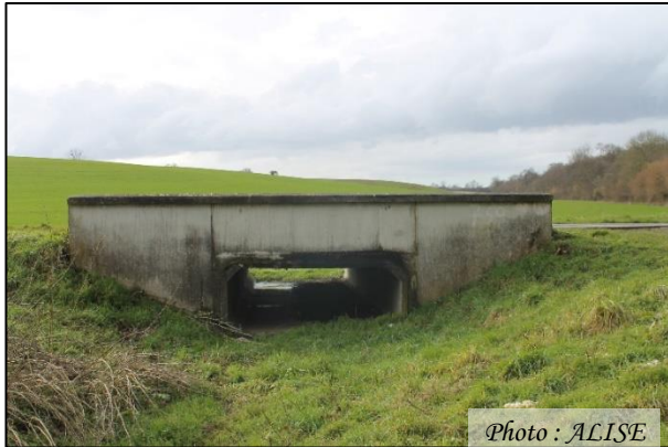
Photo n°9 Ouvrage sous RD 90
