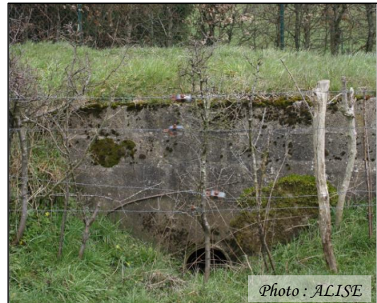
Photo n°14 Buse sous la rue du Four à Chaux
