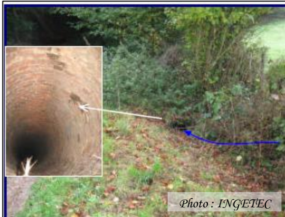
Photo n°3 Puisard/ avaloir en bordure du chemin communal – Vue dans l'avaloir en médaillon
