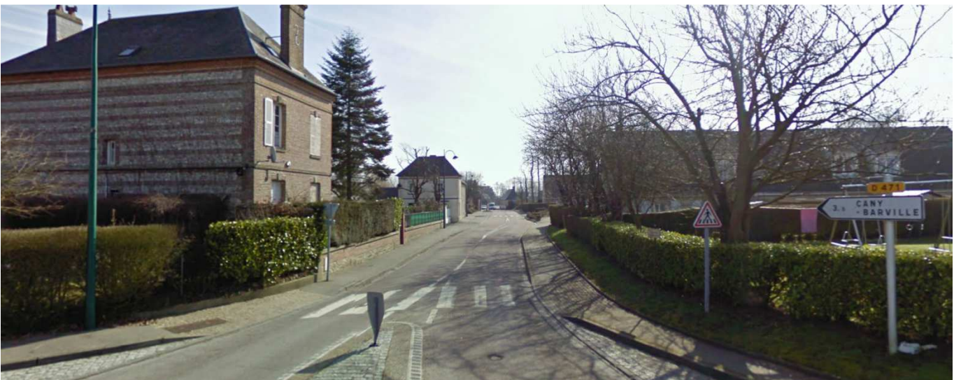
Trottoir aménagé dans le centre-bourg (Rue de Maldestour)
