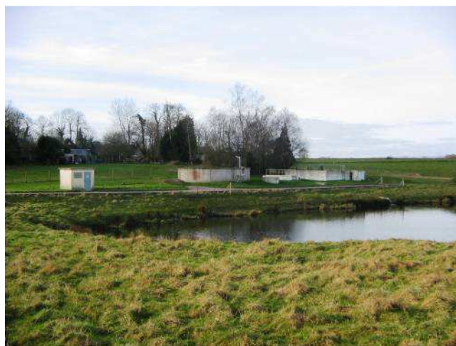
Station d'épuration du bourg
