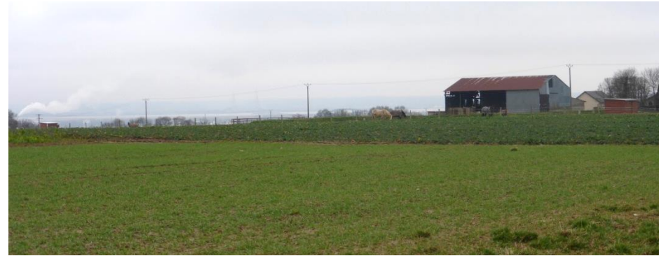
Bâtiment agricole - Videmare
