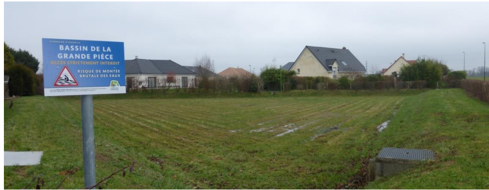
Ouvrage de lutte contre le ruissellement
