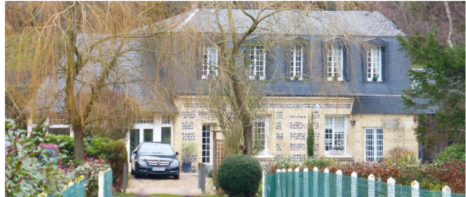
Bâtiment remarquable – La Vallée
