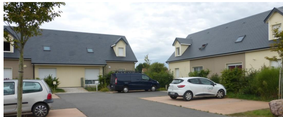
Logements locatifs – Saint-Laurent-de-Brévedent
