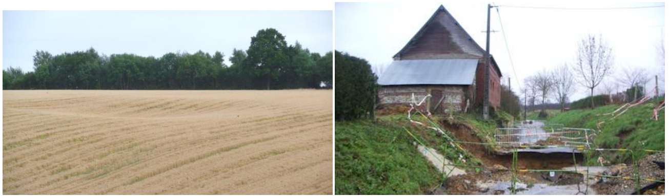
Figure 47 : Affaissement / effondrement (source Explor-e)
