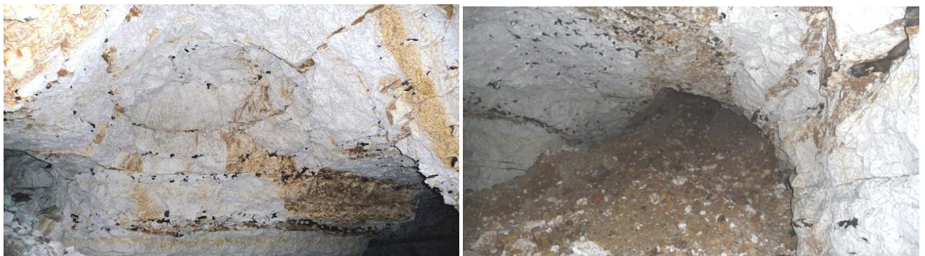
Figure 48 : formation d'une cloche de fontis au ciel d'une marnière / déboussage (source Explor-e)
