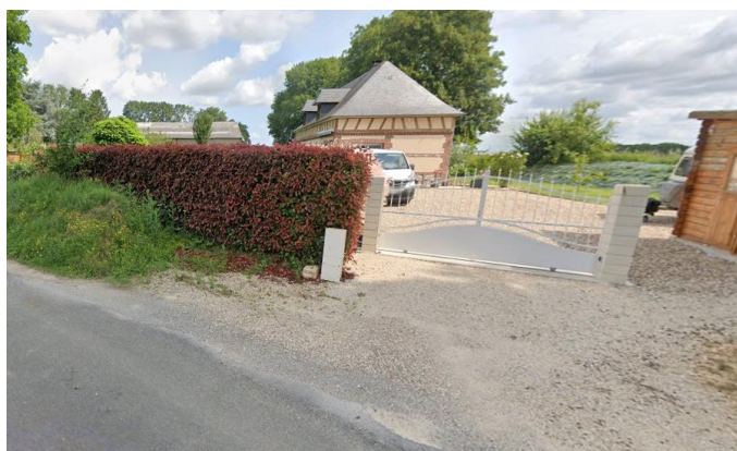
constructions déjà existantes de l’autre côté de la voie
