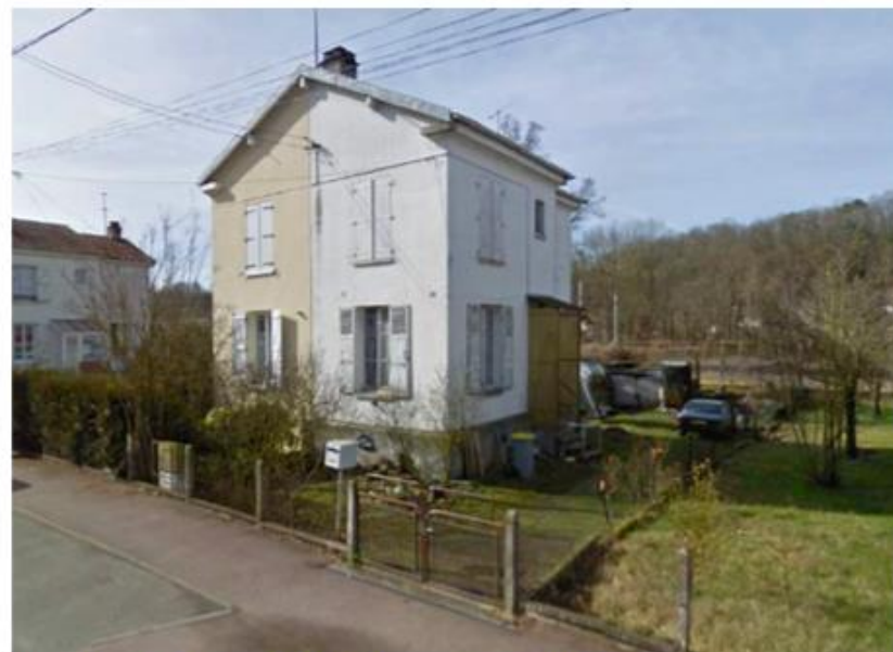
Une maison ouvrière de Bagneaux-sur-Loing , les enduits de façade de couleur différente montrent qu'il s'agit de deux logements mitoyens
