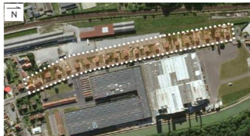
En orange, les maisons ouvrières le long de la RD 40, face aux usines verrières de Bagneaux-sur-Loing
