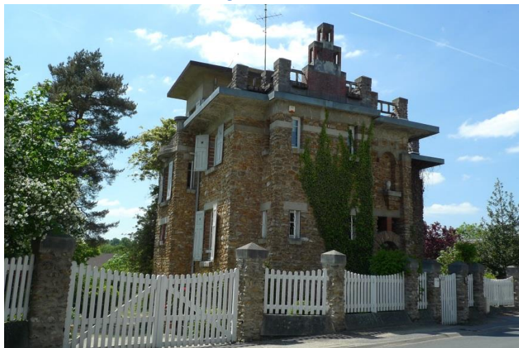
Maison rue de la Tour Maubourg
