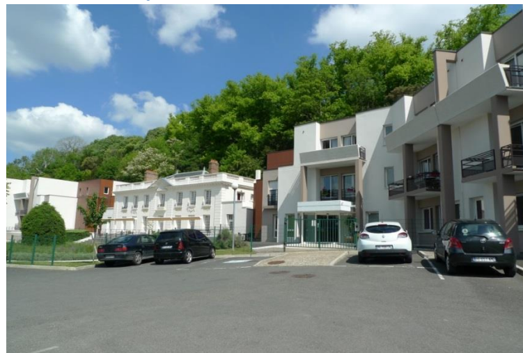
Le château des Bruyères réhabilité.
