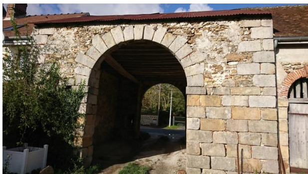
A gauche : rue du Piffon
