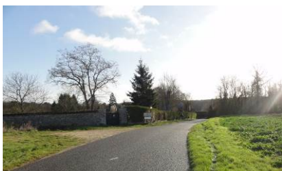
Entrée de qualité au Nord, marquée par le mur de clôture en pierre
