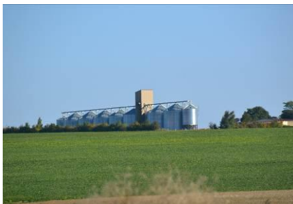
SILOS A L'EST Source : source communale
