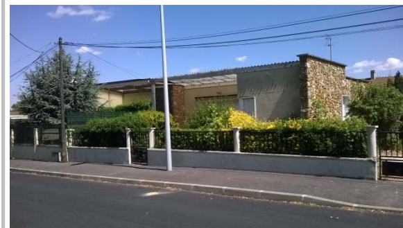
Les maisons de l'ensemble de la Colline Saint-Denis
