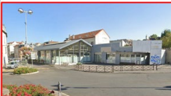
Entrée du secteur Foch.
