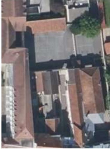
Photo aérienne école élémentaire Saint-Albert, source : Géoportail
