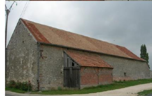
Bâtiment agricole en pierre
