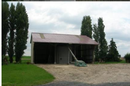
Bâtiment agricole en tôle
