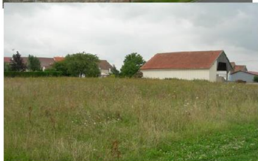
Bâtiment en tôle avec bardage bois
