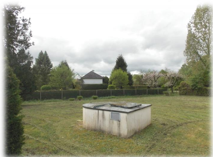
Photo 13 : Le puits de captage
