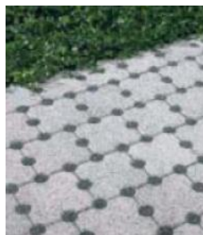
Exemple de pavés perforés (Source : Grand Lyon, Fiche n°1 Revêtements de surface poreux, d'après FEBESTRAL)
