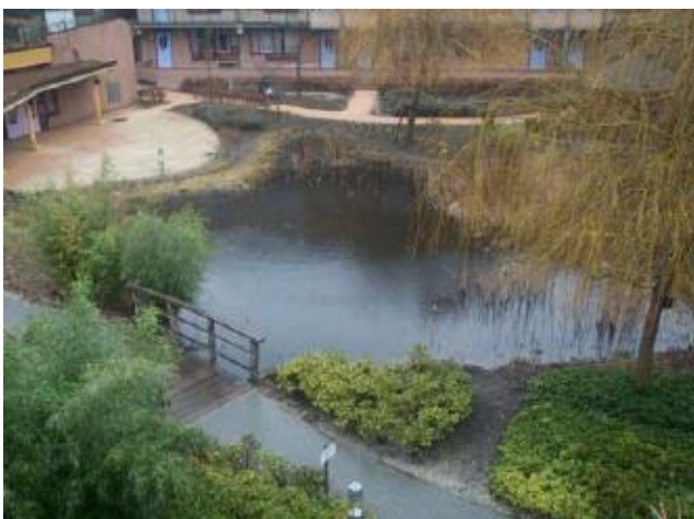
Mare d'infiltration (Source : Erik P.C. ROMBAUT, 2010. « Gestion durable de l'eau en ville. Vers un écopolis résistant au climat »)
