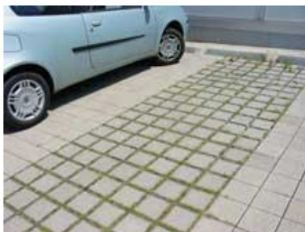
Exemple de pavés non jointifs (Source : www.crit.archi.fr , Étude sur l'imperméabilisation en région bruxelloise, 2006)
