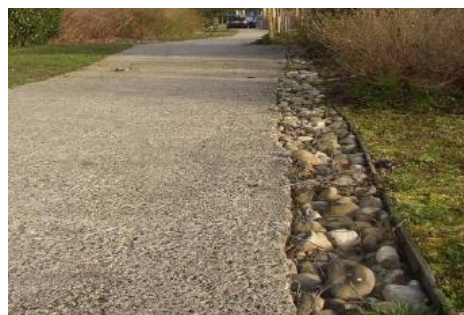
Petite tranchée le long d'un espace piétonnier (Source : Grand Lyon, Fiche n°03)
