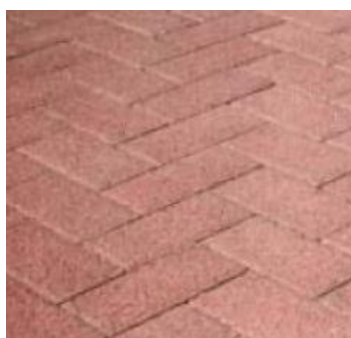
Exemple de pavés poreux (Source : Grand Lyon, Fiche n°1 Revêtements de surface poreux, d'après FEBESTRAL)
