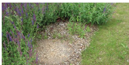
Puits d'infiltration (Source : Fiches CG 92)
