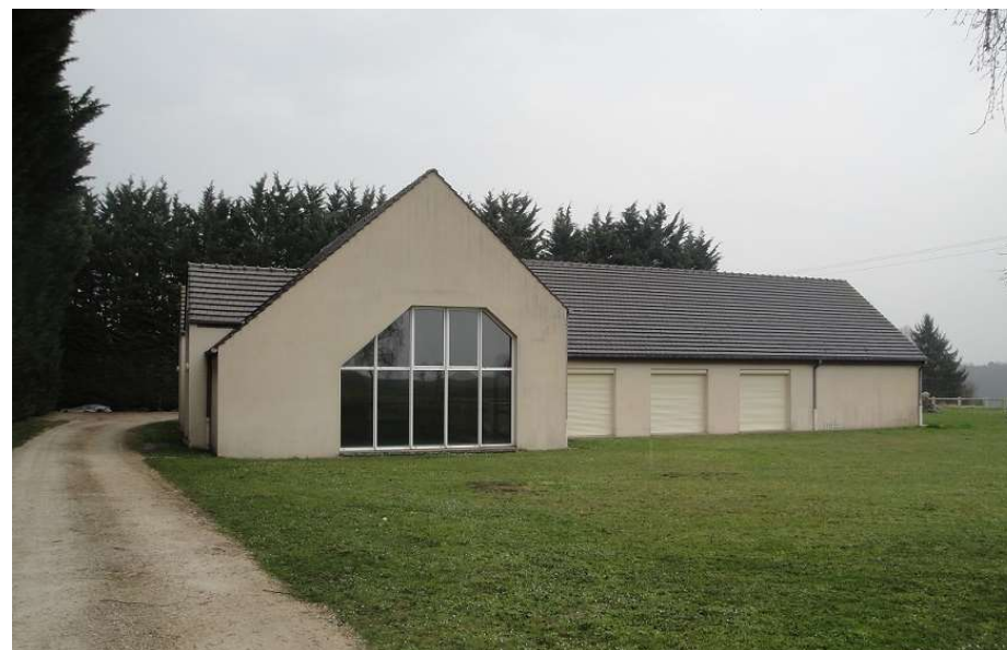
La salle des fêtes de Paley (Source : visite sur site)
