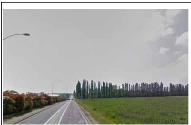
3 Vue depuis la RD 17A en direction de la Zone Industrielle
