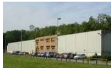
Station d'épuration Rue GAMBETTA à VILLENVOY
