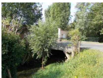
Figure 90 : Vue 1 – Ouvrage de franchissement du Morbras
