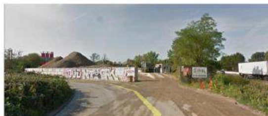
9 Entrée dans la zone occupée par des entreprises
