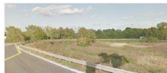
5 Vue de la Francilienne, au centre de l'échangeur
