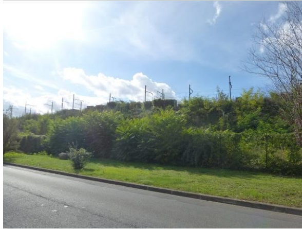
Photo 14 : Voie ferrée en remblai depuis la rue Benjamin Franklin
