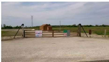
Puits de pétrole sur Verneuil l'Etang
