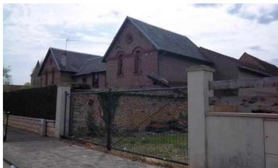
Corps de ferme - 23 rue Jean Jaurès
