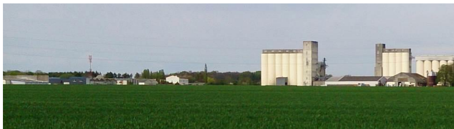
Lisière urbaine de la zone d'activités
