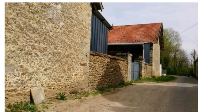
Ancien corps de ferme – Hameau de Vernouillet
