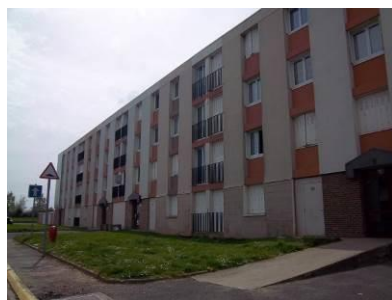
Barre d'immeuble - Rue des Primevères
