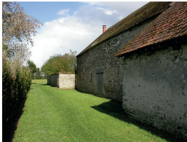
Rue de la Mairie, beau bâtiment traditionnel
