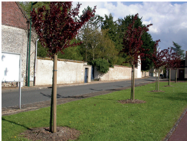
Rue de la Mairie : qualité des murs de clôture
