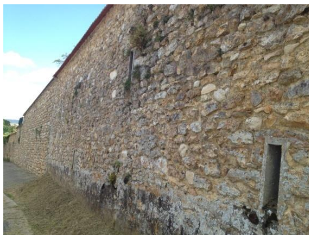
Figure 65 : Mur en pierre blanche
