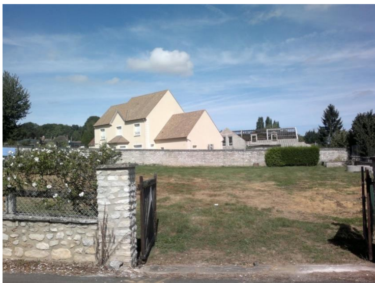
Figure 39 : Construction en cours et construction des années 2000
