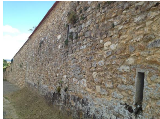
Figure 7 : Mur en pierre blanche
