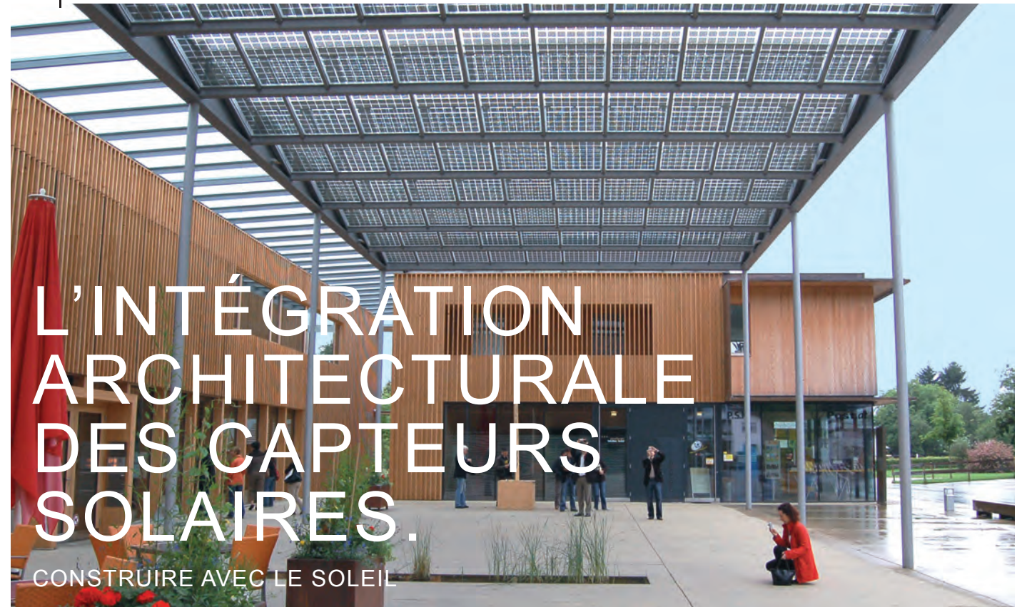
Un vélum de capteurs photovoltaïques abritent une place publique. Ludesch (Vorarlberg, Autriche) © CAUE 78
