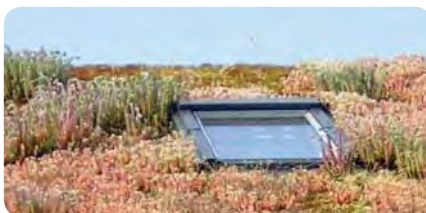
UNE TOITURE QUI VARIE SELON LES SAISONS
