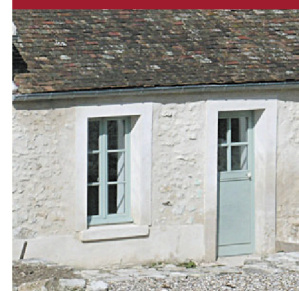
Décors de façade : bandes plates en plâtre
