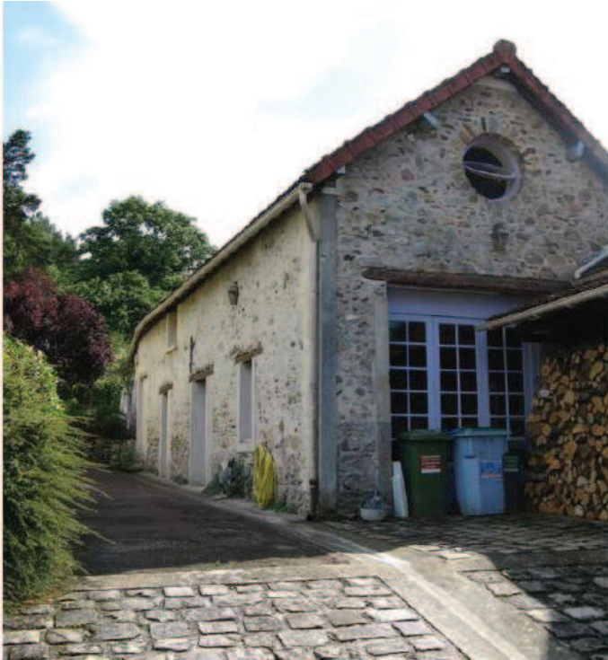
1- Cour pavée restaurée
